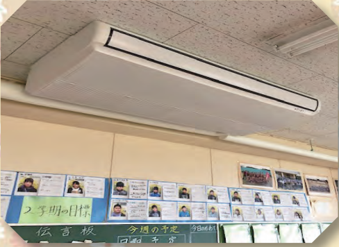
市内各小学校空調設備工事了 (令和元年9月30日)
