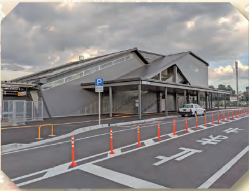
榎戸駅橋上駅舎・自由通路 供用開始 (平成31年1月21日)
