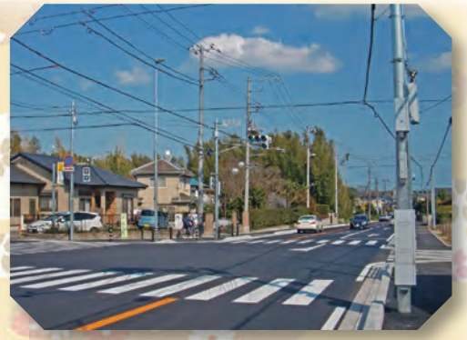
沖入口交差点改良工事が完了 (平成31年3月15日)
