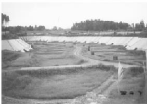
八街市一般廃棄物最終処分場
