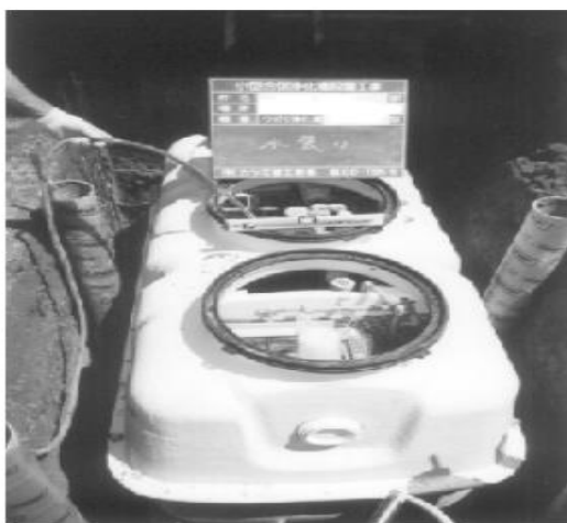
家庭用小型合併処理浄化槽
