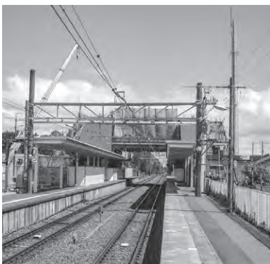
▲工事中の榎戸駅
