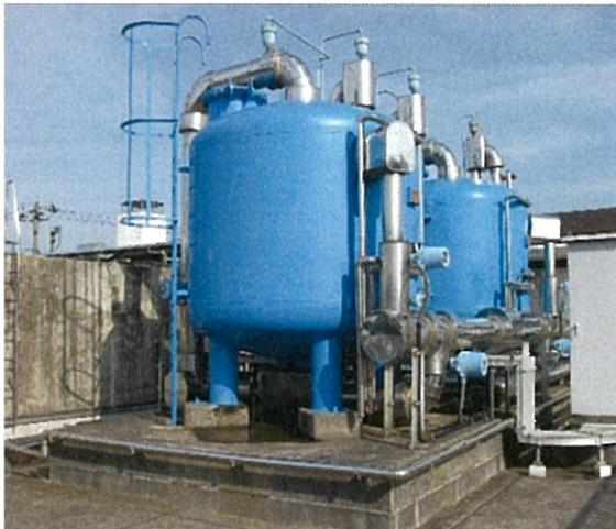
写真3.4.1 第1配水場急速ろ過機
