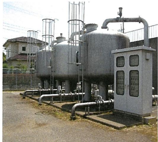
写真3.4.2 第2配水場急速ろ過機
