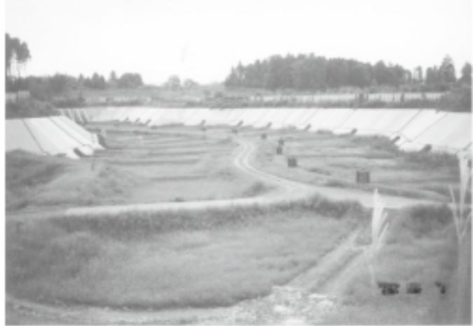
八街市一般廃棄物最終処分場
