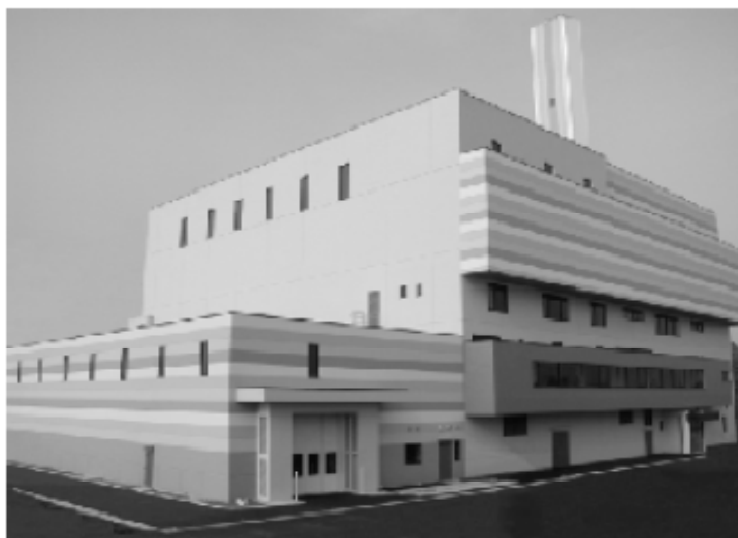
平成14年12月から稼働開始したクリーンセンターの新焼却処理施設
