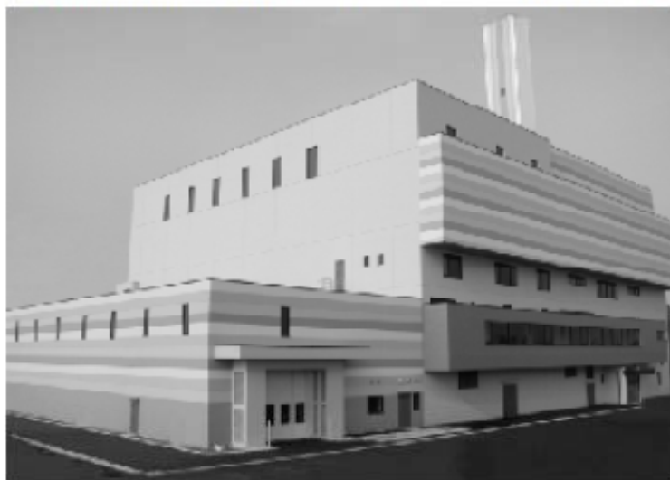
平成14年12月から稼動開始したクリーンセンターの新焼却処理施設
