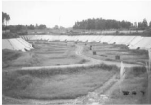
八街市一般廃棄物最終処分場
