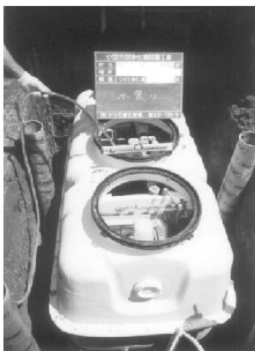
家庭用小型合併処理浄化槽
