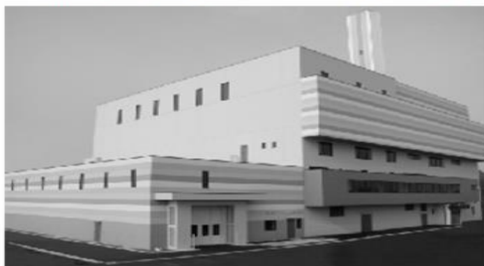
平成14年12月から稼働開始したクリーンセンターの焼却処理施設
