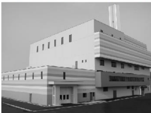
平成14年12月から稼働開始したクリーンセンターの焼却処理施設
