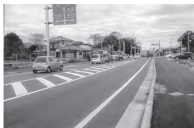
▲整備される道路
