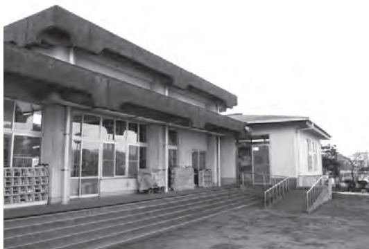
▲雨漏り等が改修される実住保育園
