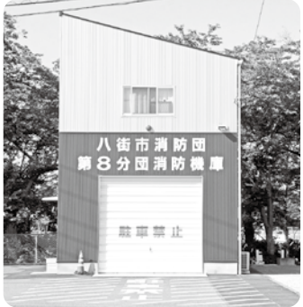
3月末に移転した消防機庫
