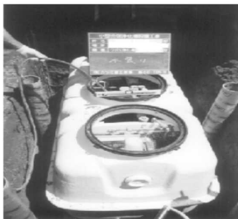
家庭用小型合併処理浄化槽
