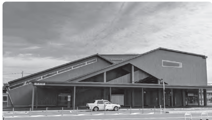
榎戸駅の駅舎橋上化
