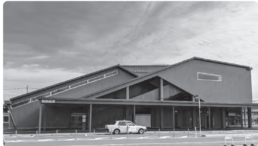
榎戸駅の駅舎橋上化
