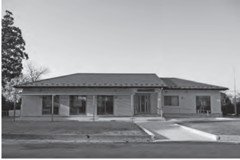
完成した 住野区コミュニティセンター
