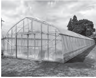
▲補強、改修されたパイプハウス
