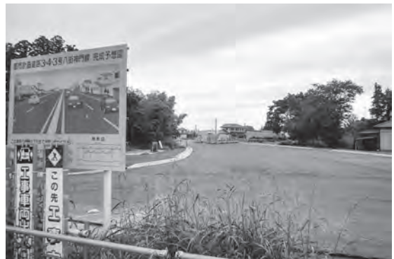
▲工事中の都市計画道路3・4・3号八街神門線
