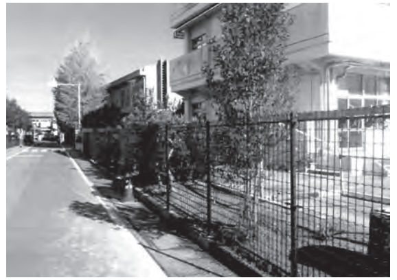
修繕した八街東小学校のフェンス
