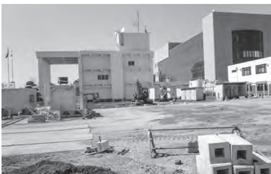
▲建物解体された第2庁舎跡地
