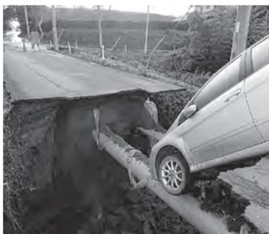
▲復旧工事にむけ測量、設計等を行っている市道219号線の道路陥没状況
