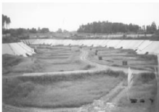
八街市一般廃棄物最終処分場
