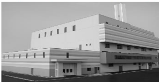
平成14年12月から稼働開始したクリーンセンターの焼却処理施設
