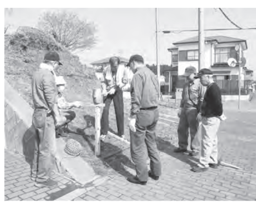
木柵の交換作業を行いました
