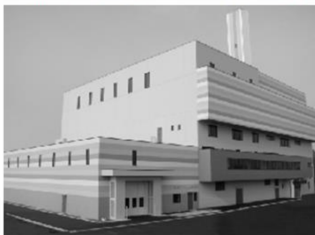
平成14年12月から稼働開始したクリーンセンターの焼却処理施設
