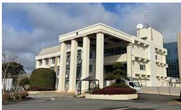
八街市役所第一庁舎
