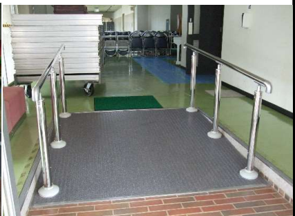
大会議室北側入口
