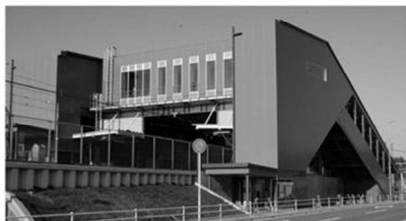
J R 有明駅橋上駅舎及び自由通路
