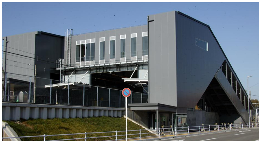
J R 青森駅橋上駅舎及び自由通路
