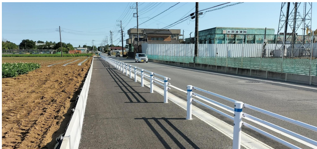
工事により新設された歩道
