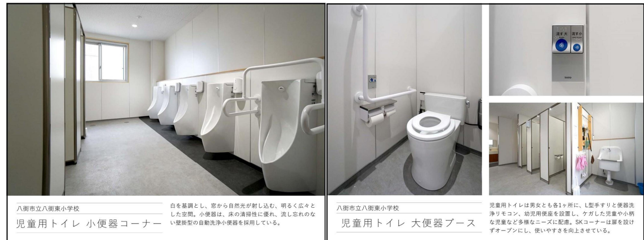
改修工事を実施した八街東小学校の児童用トイレ
