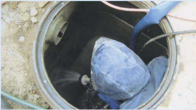
3.浄化槽内清掃
