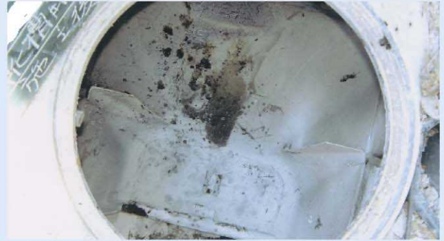
2.浄化槽解体施工
