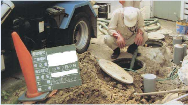
1.浄化槽汲取り
