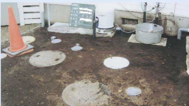
7.雨水貯留槽 完成
