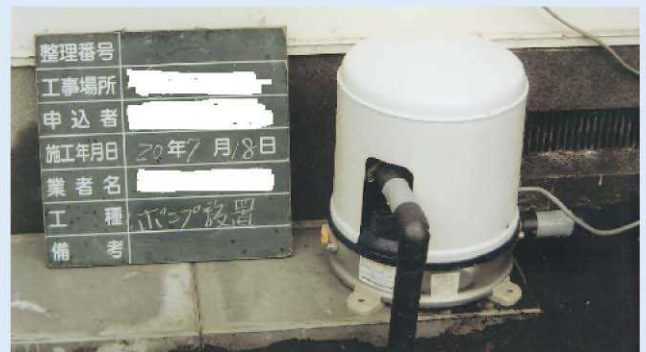
6.水中ポンプ設置
