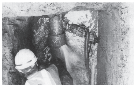
▲配水管漏水修理
