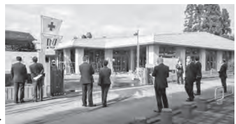
老人福祉センターの工事を視察▶
