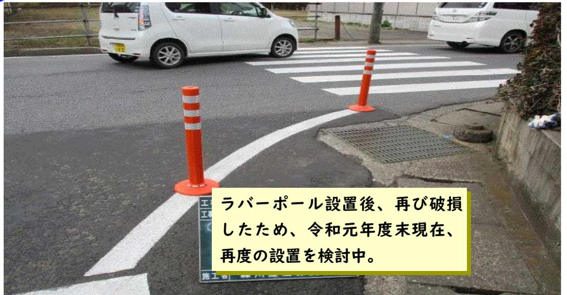
ラバーポール設置後、再び破損したため、令和元年度末現在、再度の設置を検討中。
