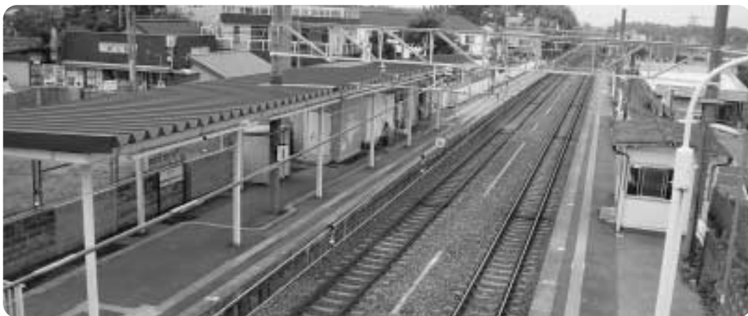
一日7早い快速電車停車(写真:榎戸駅)
