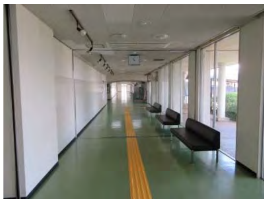
3 棟をつなぐ廊下
