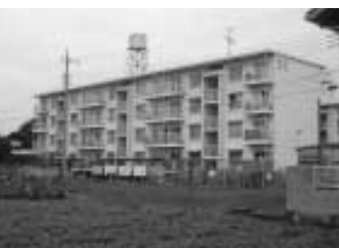
▲外装工事の終わった九十九団地
