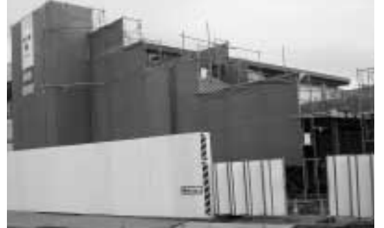
▲建設が進む八街駅南口下り側階段
