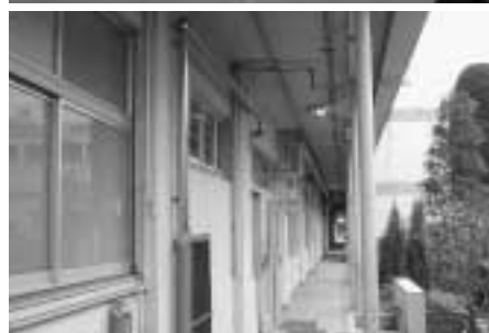
▲昭和41年に建築された八街中央中学校校舎
