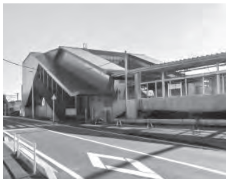
▲駅舎橋上化・東西自由通路が整備されたJR榎戸駅
